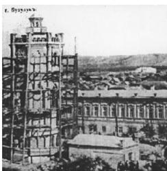
Строительство водонапорной башни
